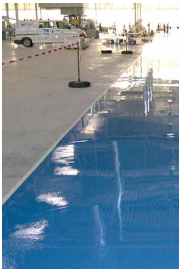
Industriehalle: Monolithische Bodenplatte inkl. Beschichtung
